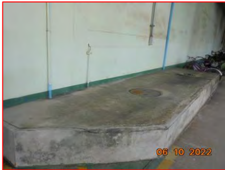
ภาพที่ 2.2-1 ระบบถังบำบัดสำเร็จรูป (SATs)
