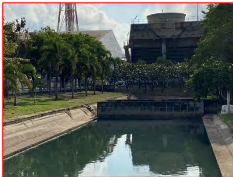
ภาพที่ 2.2-2 บ่อรวบรวมและดักตะกอน (Collection Pond)
