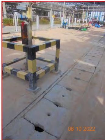
ภาพที่ 2.2-8 รางระบายน้ำฝนภายในพื้นที่โครงการ
